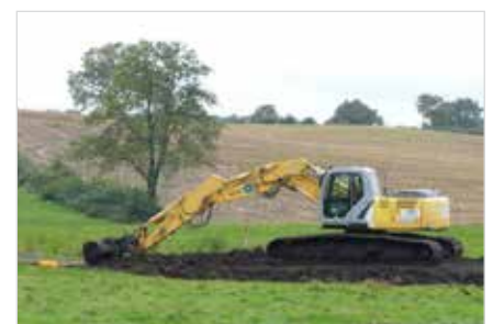
Dammbau in Hütten
