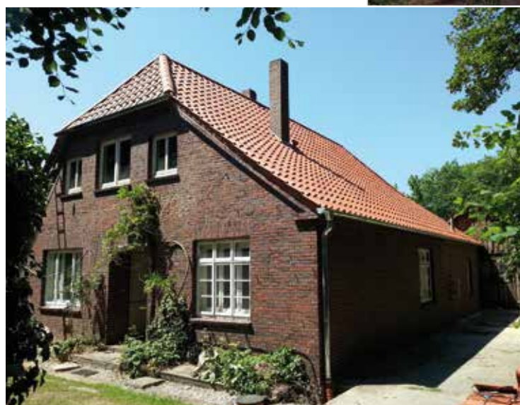
... mit neuem Dach, neuer Drainage, neuer Elektrik und neuen Pächtern.
